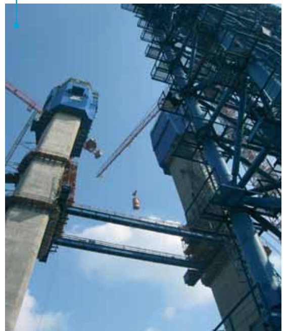
Pyloni rakenteilla. Kuva: JSC Institute Stroiproject
