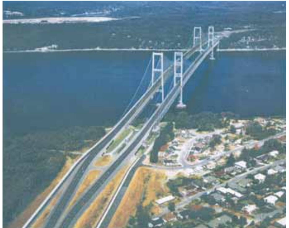
Kuva 2. Kuvasovitelma Tacoman 3- ja 2-sillasta (uusi silta vasemmalla). Ulkonäkösyistä 3-siltaan tulee 2-sillan tavoin korkea ristikkopalkkikansi - matalampi virtaviivainen kotelopalkki olisi muutoin saattanut olla edullisempi.
