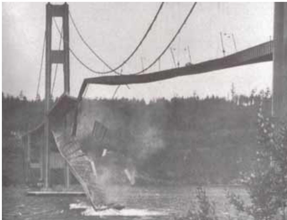
Kuva 1. Tacoman 1-sillan "Gallopning Gertie" aika päättyi äkisti vain 4 kk ikäisenä 7.11.1940. Silta ikään kuin "räjähti" navakassa tuulessa (n. 20 m/s) - ei mikään hirmumyrsky.
