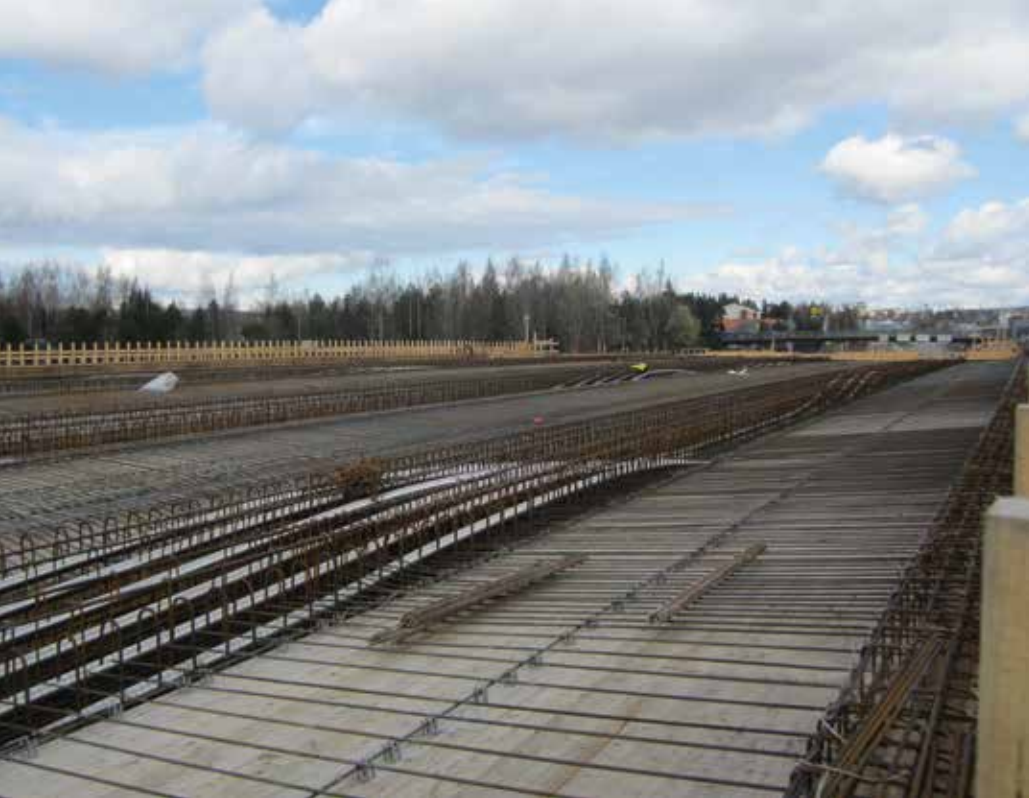
Launeen risteys sillan tehdään Mt167:n urakassa. Kehätien liikenne kulkee sillan ali tulevaisuudessa.
